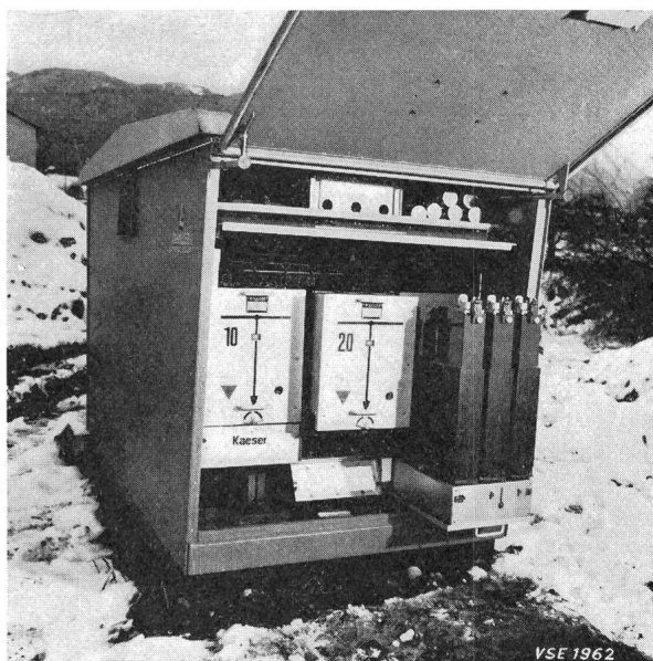
Fig. 2 Hochspannungs-Schaltschrank
