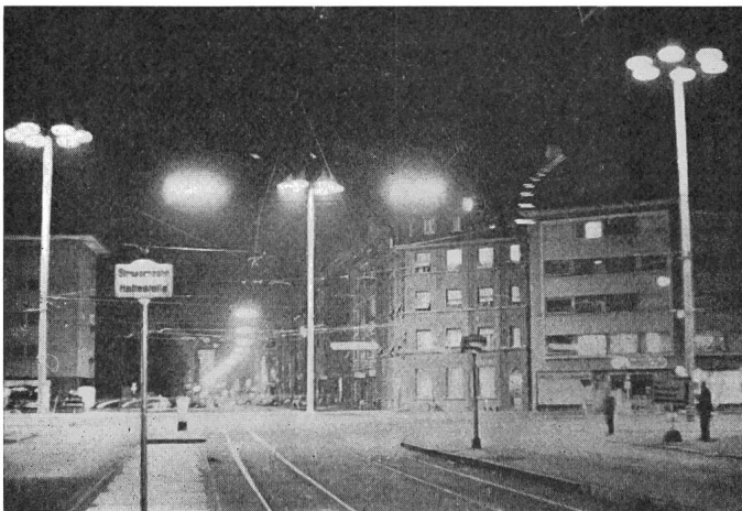
Fig. 6 Platzbeleuchtung mit 3 Masten ausgerüstet mit je 6 HQL-Tiefstrahlern von 400 W Lichtpunkthöhe 16 m
