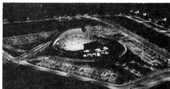
Pittsburgh Civic Arena – Die mächtige Kuppel öffnet sich unter Sternenhimmel, schliesst sich bei Regen oder Wind.
