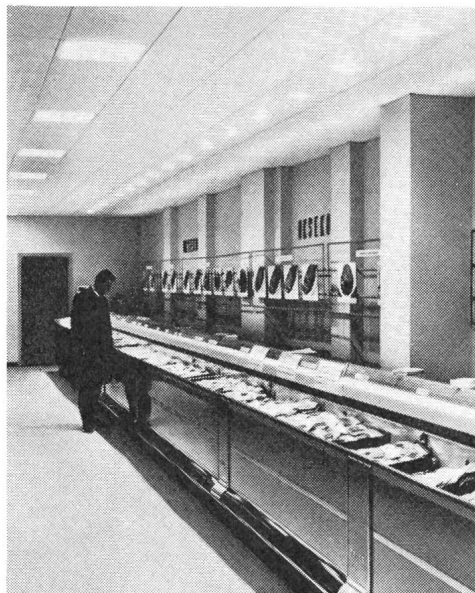
Cool-Beam-Lampen können – verglichen mit anderen Glühlampen gleicher Leistung – die Temperatur in offenen Tiefkühltruhen um 1\frac{1}{2} –3 °C senken.
