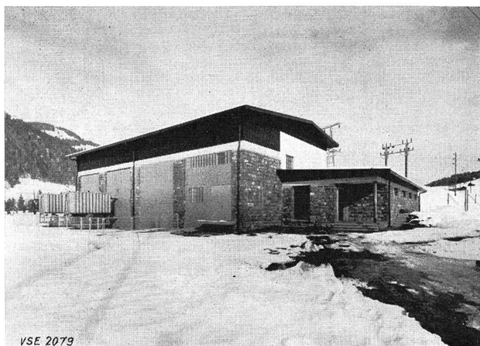
Das neue Unterwerk Saanen 50/16 kV
