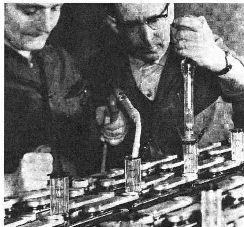
Fig. 1 Einfache Kontrolle und Wartung stationärer Batterien dank der Electrona-Einfüllpfropfen
