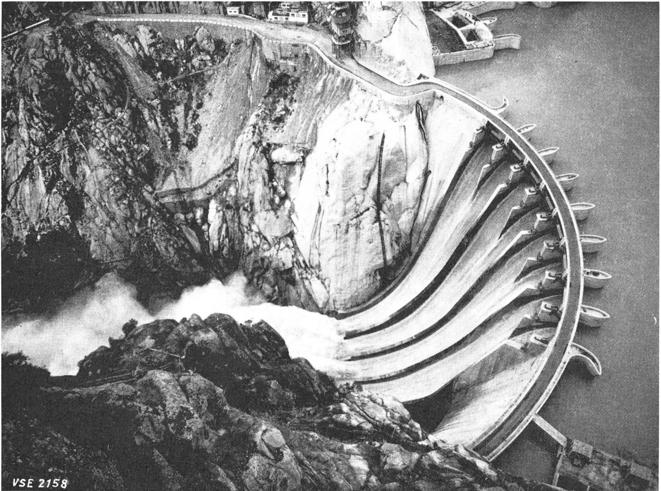
Fig. 4 Überlauf von 2800 \text{ m}^3\text{s}^{-1} beim Stauwehr Aldeadávila am Duero
