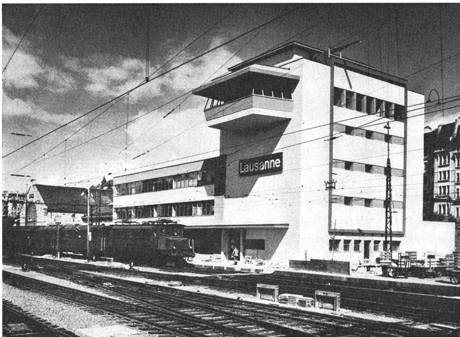
Fig. 2 Poste directeur de la gare de Lausanne
