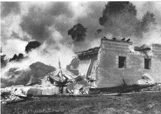
Fig. 16 Durch Blitzschlag verursachter Brand eines Gebäudes ohne Blitzableiter
