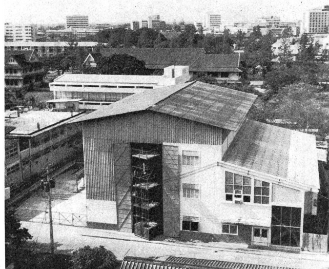
Fig. 6 Ansicht des Laboratoriums von Norden
