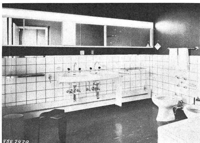
Direktheizung im Badezimmer
