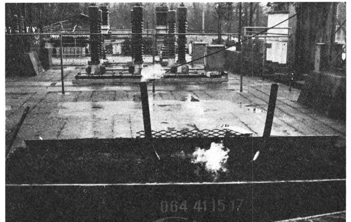
Fig. 4 Beispiel eines Versuches mit Lochbildung im Rohr infolge Kurzschluss-Lichtbogens
