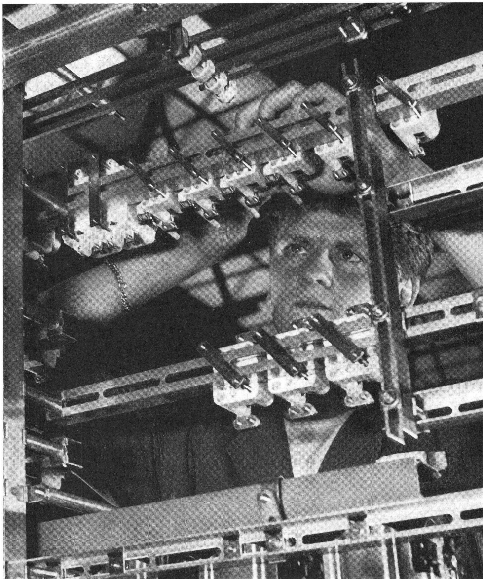
Arbeiten an einer Niederspannungs-Verteilanlage
