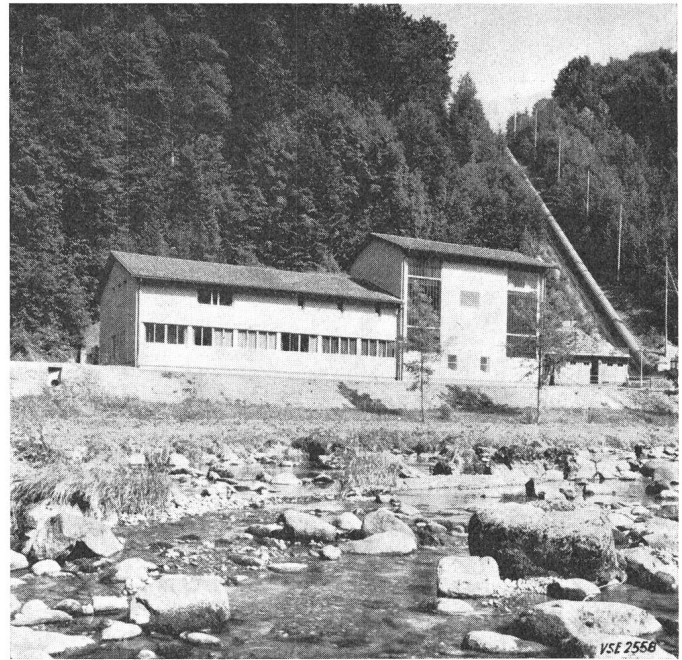
Fig. 2b Das neue Maschinenhaus Aufnahme 1967
