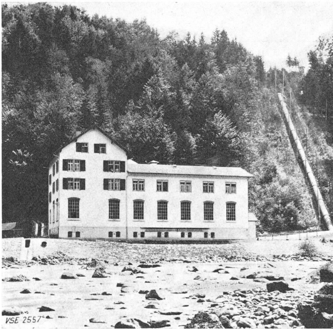
Fig. 2a Das alte Maschinenhaus in einer Aufnahme aus dem Jahre 1906
