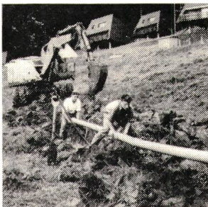
Kanalisation Schwyz: Rothenturm
