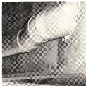
Ablauf Autobahn Vengeron
