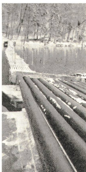
Pose de tubes protection de câbles dans l'Arve/Genève
