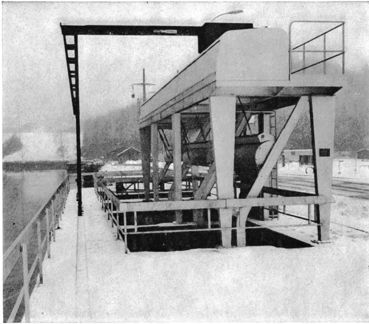
Kühlwasserfassungen der Atomkraftwerke Beznau I und II. Je 3 Rechen und automatische, stationäre Rechen-Reinigungsmaschinen.
