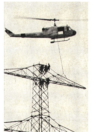
Aufstocken eines Oberteils
