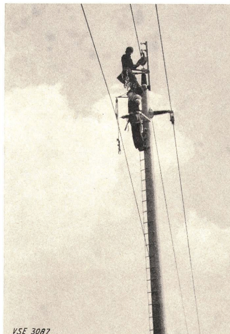
Rechts: Fig. 17 110/132-kV-Leitung, Typ FS, Prototyp
