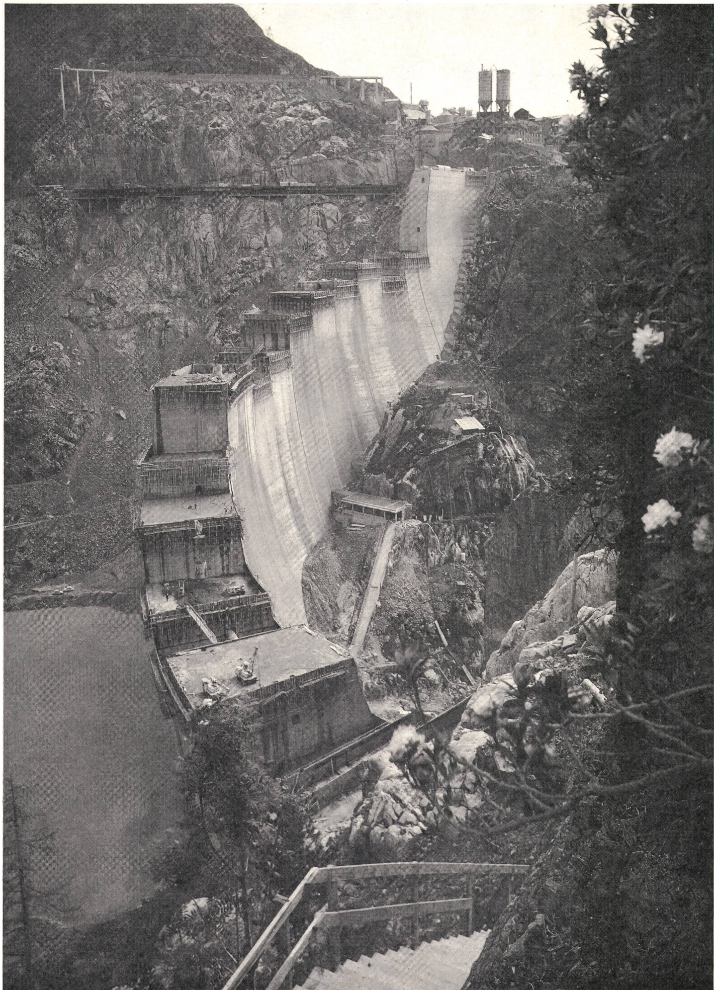
Staumauer im Bau (Eposson)
