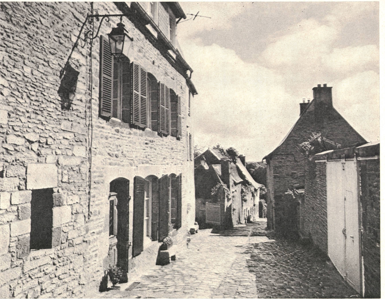
Fig. 4 Niederspannungsverteilung mittels Fassadenkabel
