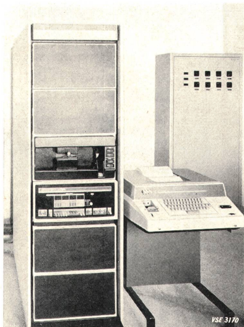
Fig. 2 Ansicht der Datenverarbeitungsanlage, mit Konsolschreibmaschine in La Bâtiaz
