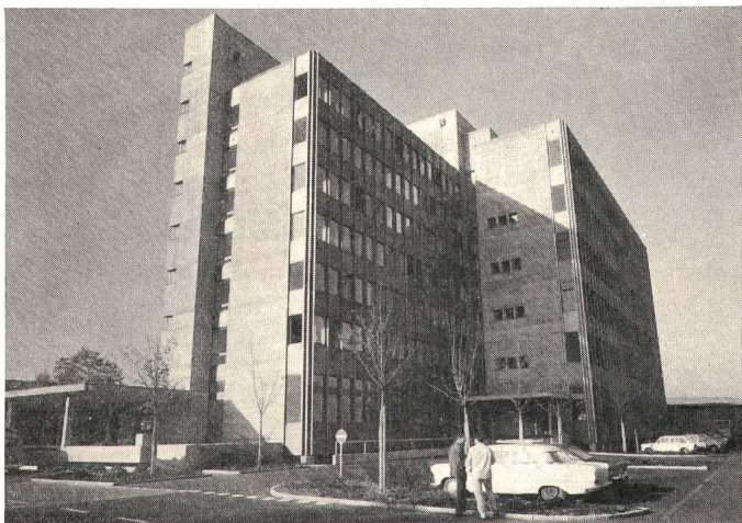
Fig. 1 Gebäudeansicht von Osten
