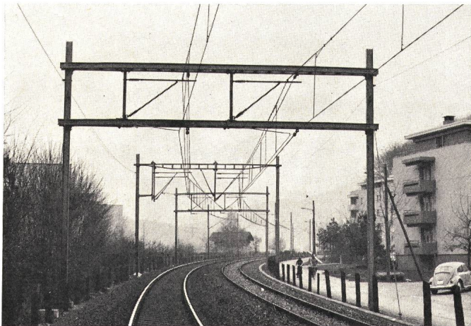
Fig. 8 2feldrige Nachspannung (entsprechend Fig. 7)
