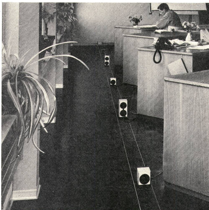
Fig. 7 Überflur-Bodenkanal (abdeckbar), mit montierten Anschlussaufsätzen
