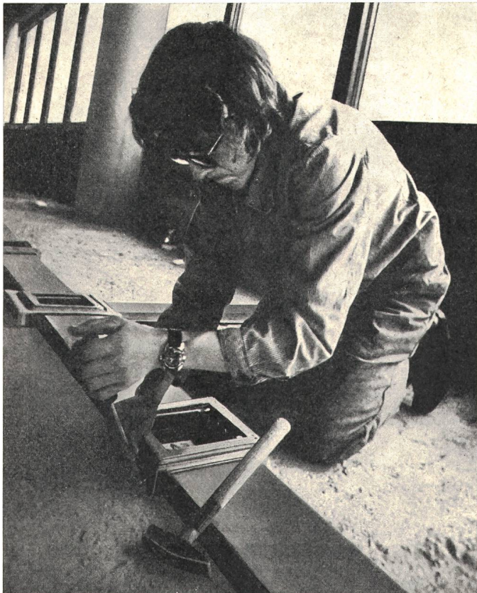
Fig. 10 Montage des Unterflur-Bodenkanalsystems
