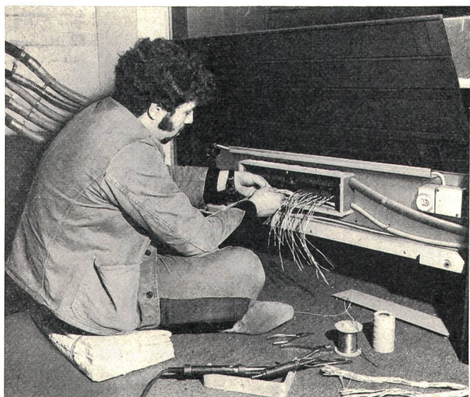
Fig. 3 Telefonmonteur beim Anschliessen eines Brüstungs-Zwischenverteilers
