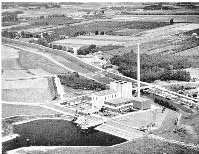
Fig. 1 Erstes Versuchs-Kernkraftwerk der Niederlande in Dodewaard mit einer Leistung von etwa 50 MW (Betriebsaufnahme 1968)
