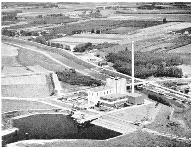
Fig. 1 Erstes Versuchs-Kernkraftwerk der Niederlande in Dodewaard mit einer Leistung von etwa 50 MW (Betriebsaufnahme 1968)
