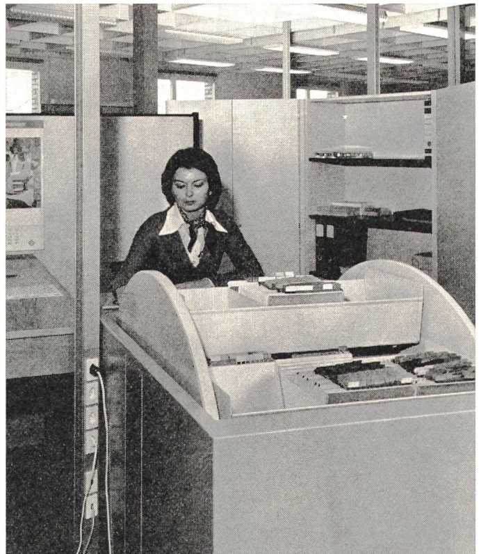
Fig. 5 Installationssäule in Grossraumbüro mit Stark- und Schwachstromanschlüssen. Zuleitungen aus der Decke
