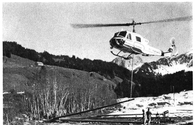
Fig. 1 Versorgungsgebiet der CKW im Entlebuch Einsatz des Helikopters beim Leitungsbau
