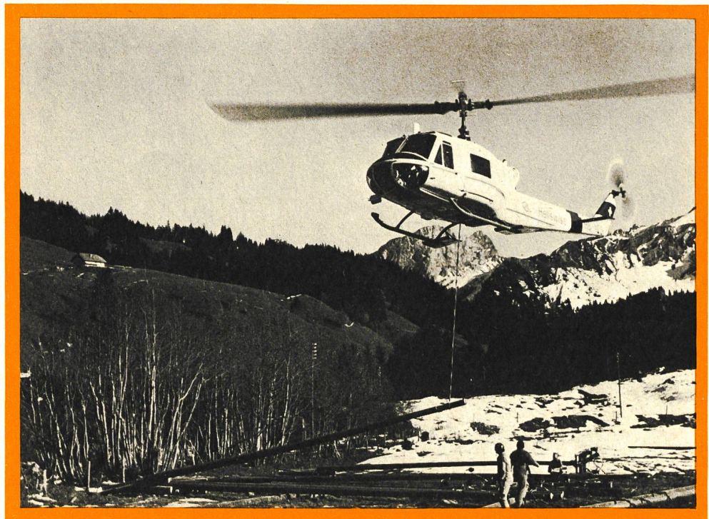
Leitungsbau mit Einsatz eines Helikopters
