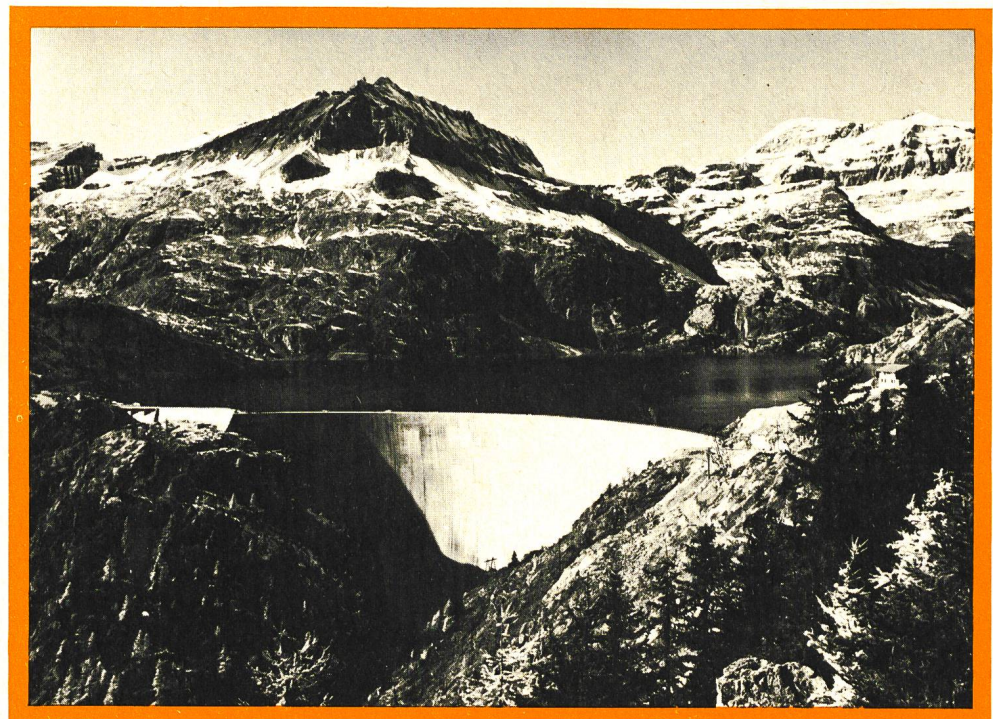
Stauanlage des Speicherkraftwerkes Emossion
