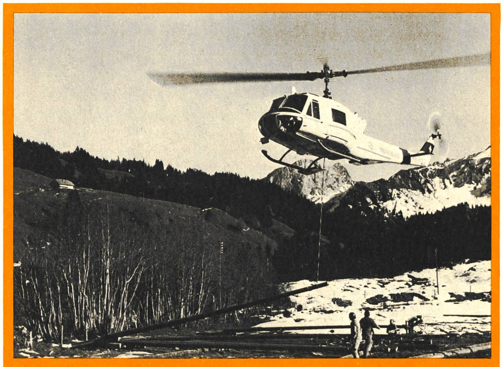
Pose de pylônes de lignes électriques aériennes à l'aide d'un hélicoptère
