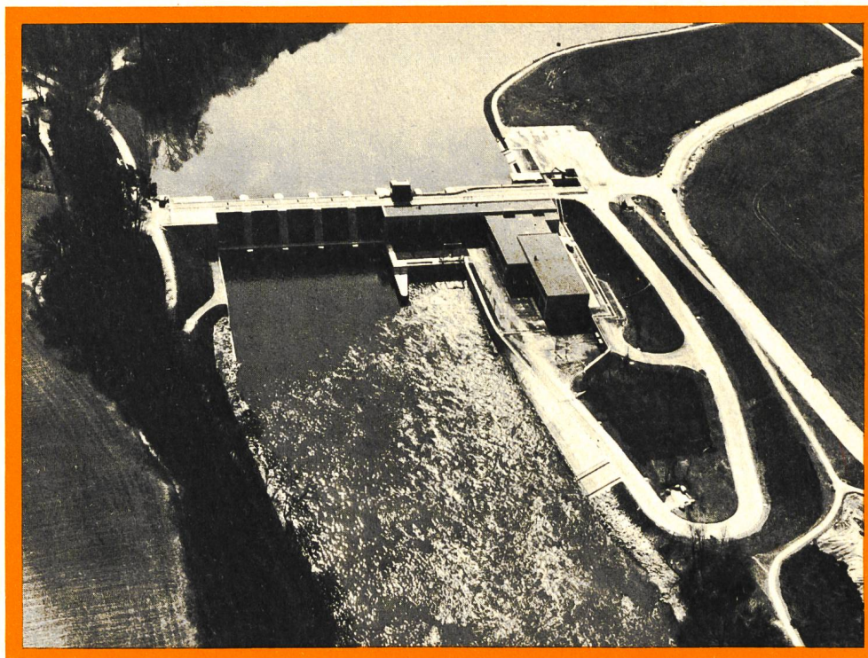
Centrale au fil de l'eau de Bremgarten-Zufikon
