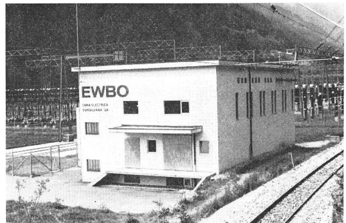
Fig. 6 Unterwerk 60/16 kV in Tavanasa Im Hintergrund 220/380-kV-Schaltanlage der Kraftwerk Vorderrhein AG
