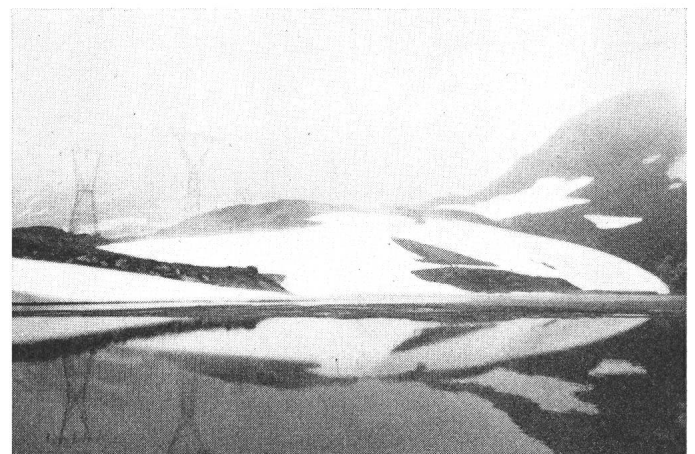
Fig. 3 150-kV- und 220-kV-Leitungen der KWB auf dem Berninapass
