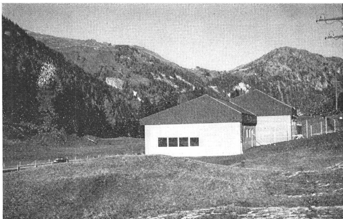
Fig. 7 Unterstation Rüti bei Splügen
