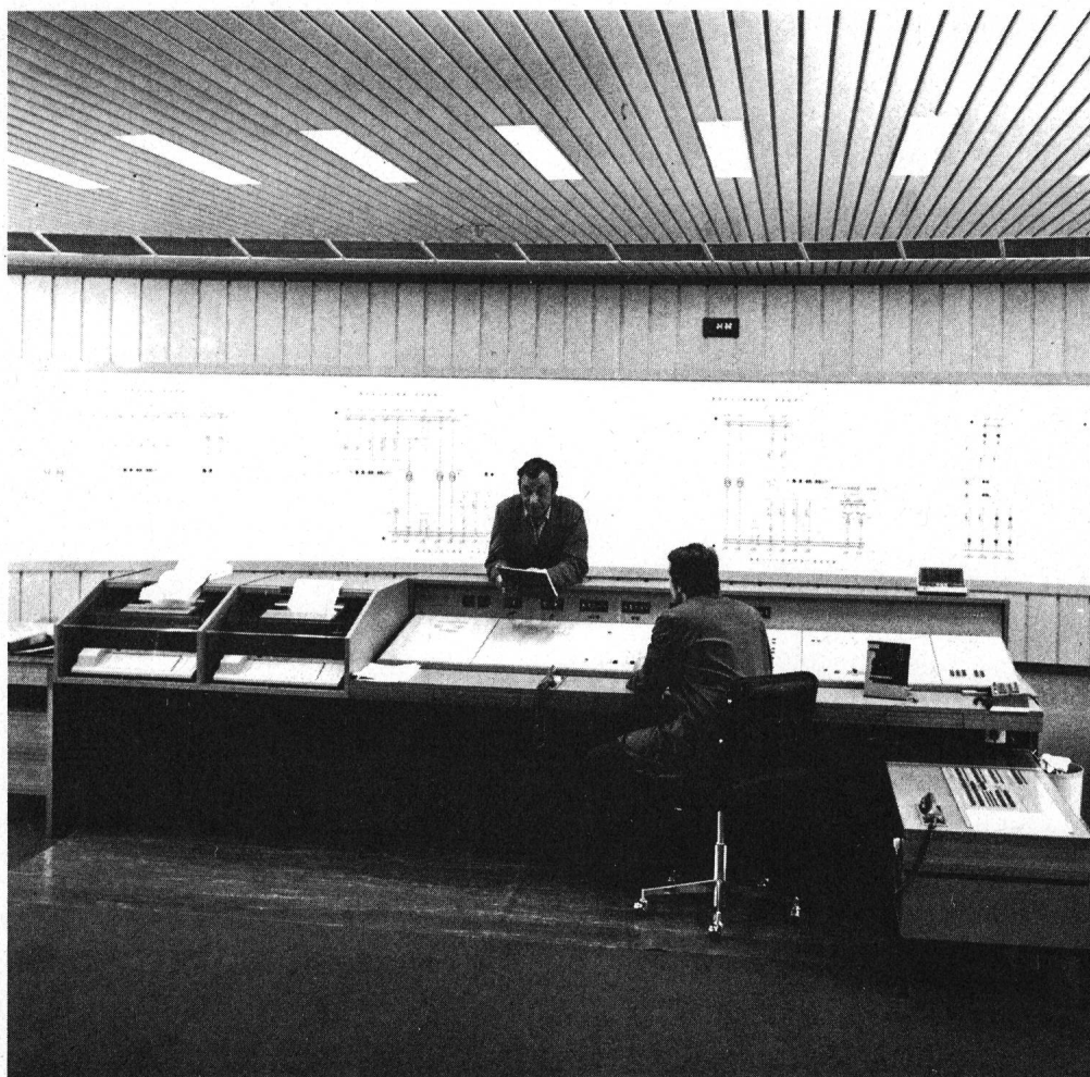
Centre régional d'exploitation du réseau à la sous-station Bassecourt des FMB
