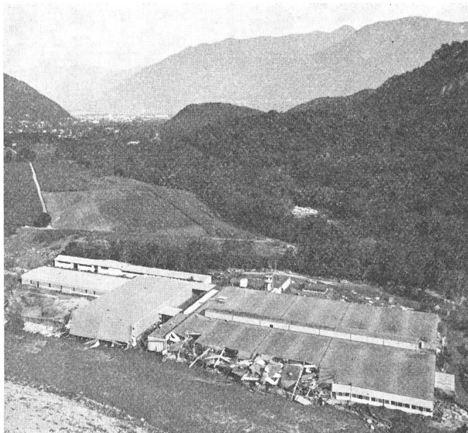
AGIE AG in Losone nach dem Unwetter
