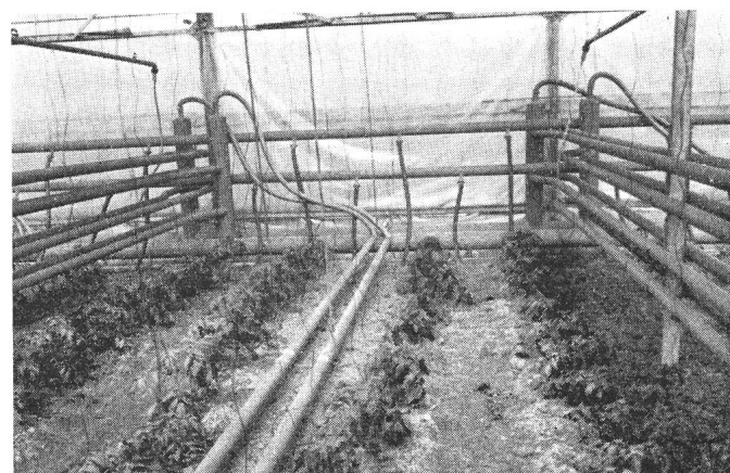
Fig. 3 Jeune culture de tomates chauffée à l'eau tiède au moyen de tubes métalliques aériens
