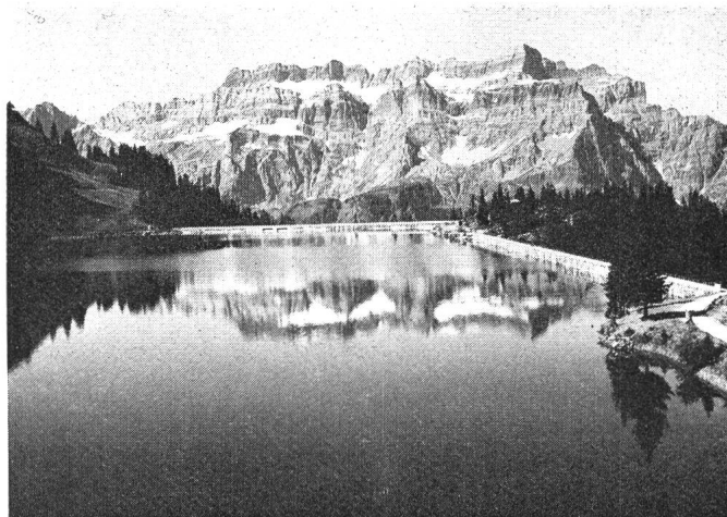
Staumauer Garichte der Kraftwerke Sernf-Niedererbach AG. Im Hintergrund der Glärnisch
