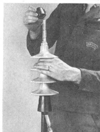
Problemlose Montage eines aufschiebbarer Freiluft-Kabelend- abschlusses
