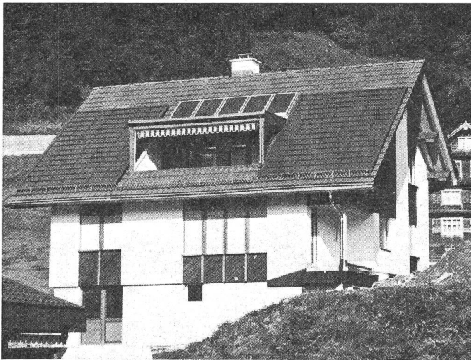
Energiedachanlage mit Absorberflächen und Sonnenkollektoren
