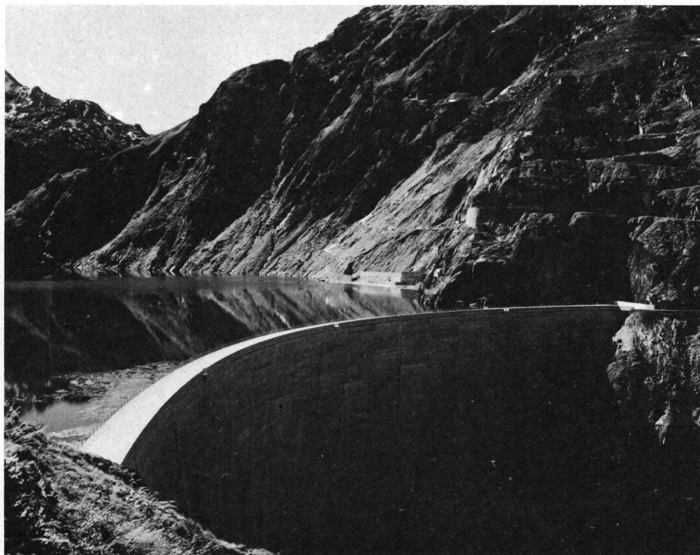
Lac d'accumulation de Curnera, Kraftwerke Vorderrhein AG
