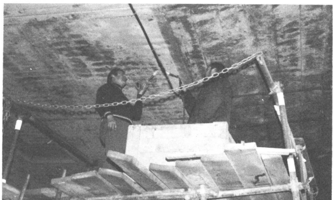
Fig. 6 Schrumpfen des Schutzschlauches auf den HF-Steckverbindungen zwischen Tunnelkabel und Zuleitung
