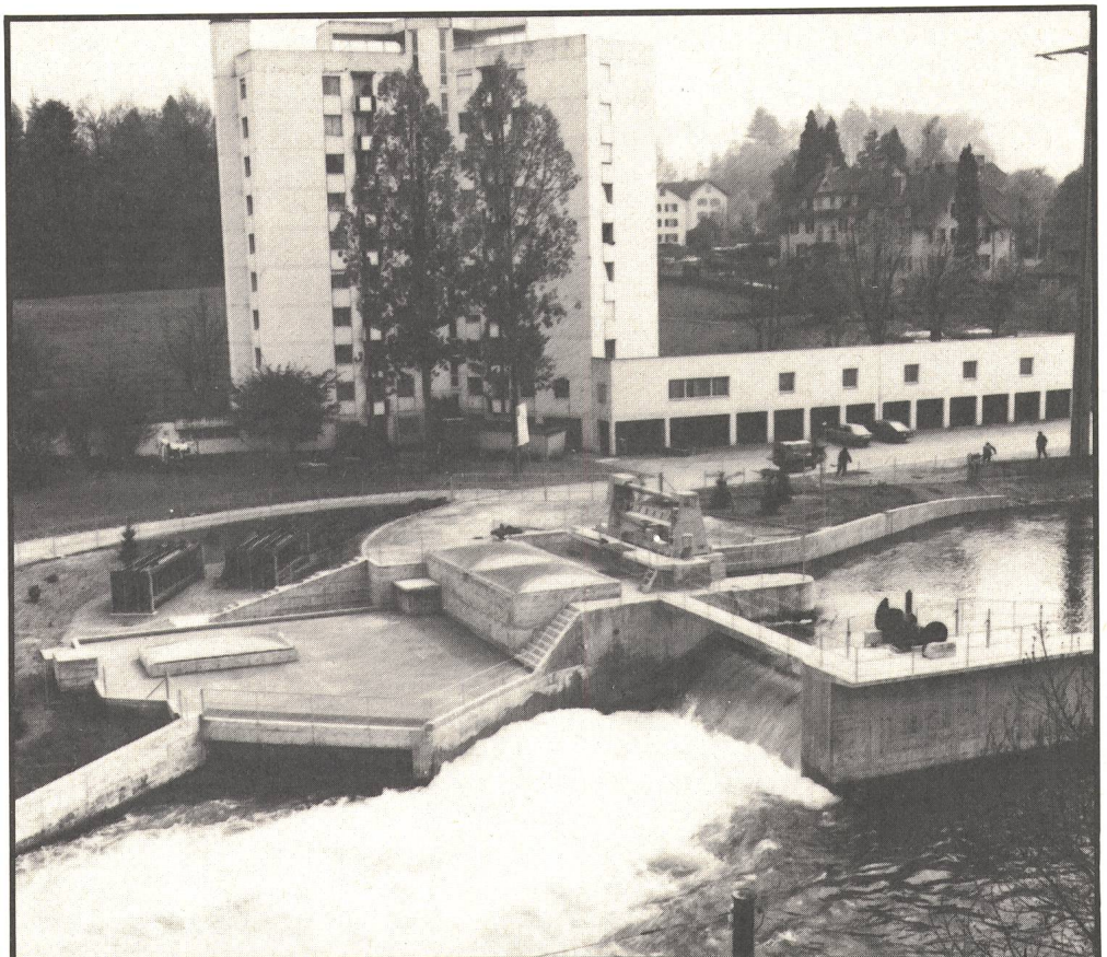
Centrale hydraulique de Perlen après rénovation
