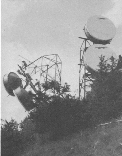
Fig. 5 Passivrelais der Richtfunkverbindung Innertkirchen-Grimsel
