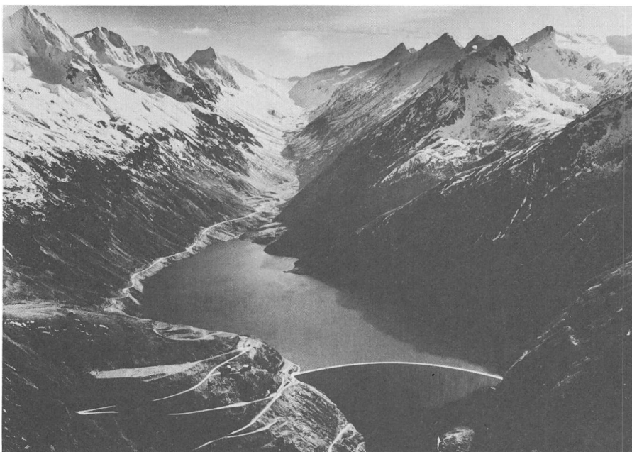
Fig. 3 Speicherkraftwerk Vorderrhein Staumauer und Stausee Nalps
