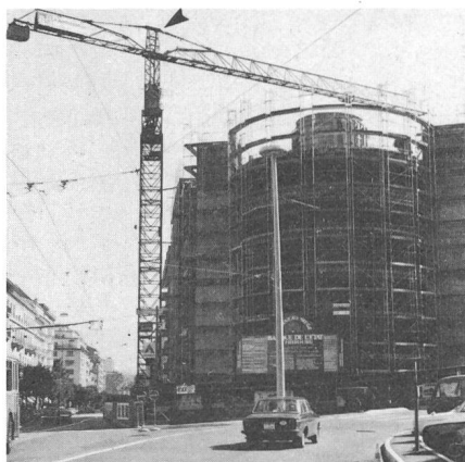
Fig. 6 Grue pivotante dont la flèche horizontale est fixée par trois axes au sommet de la grue
