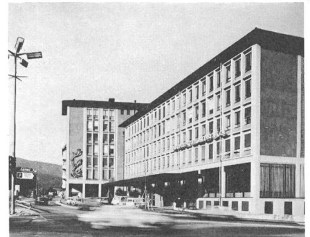
Fig. 4 Verwaltungsgebäude der Atel in Olten
