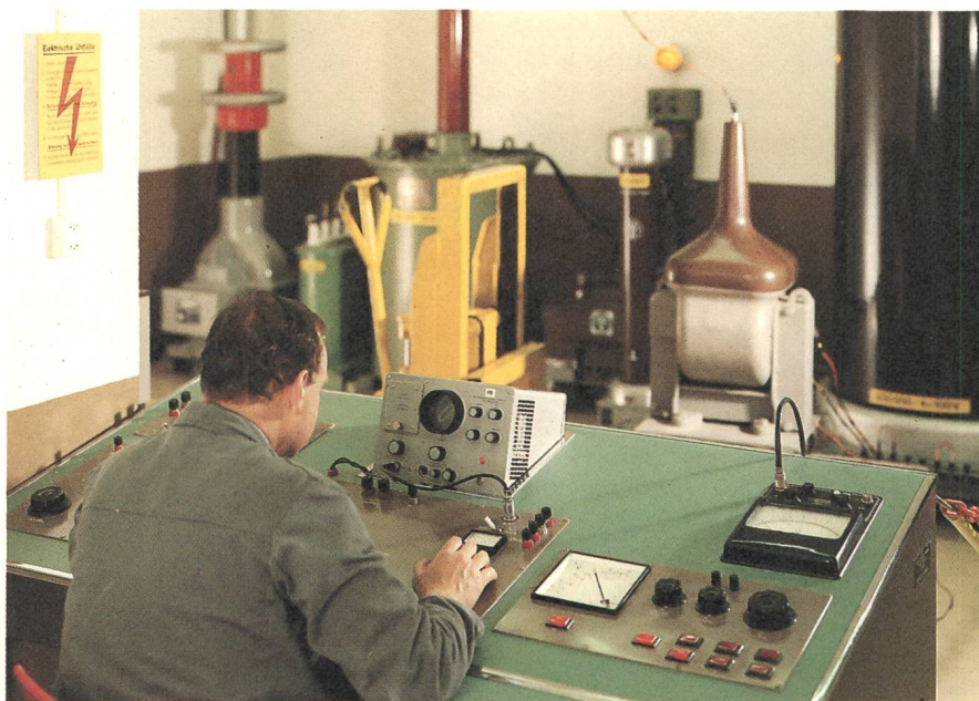
Amtliche Prüfung eines Spannungswandlers im Messwandlerlabor
