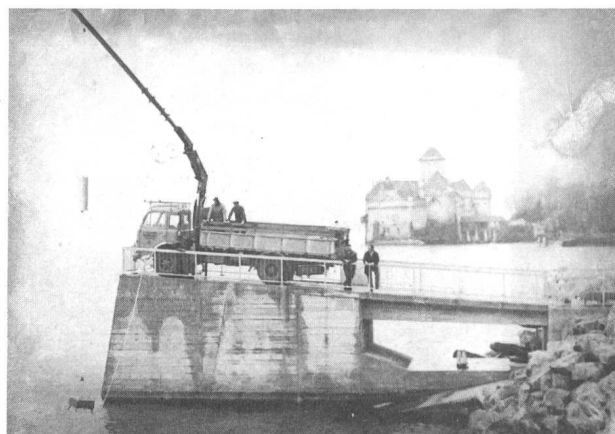
Fig. 6 Mise en place d'un flotteur de l'écran électrique et de son corps-mort
