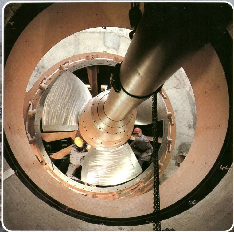
▲ Eine S-Turbine von Bell mit einem Laufrad-Durchmesser von 3200 mm deckt seit Frühjahr 1981 einen wesentlichen Teil des Energiebedarfes für die Papierfabrik Perlen/LÜ.
