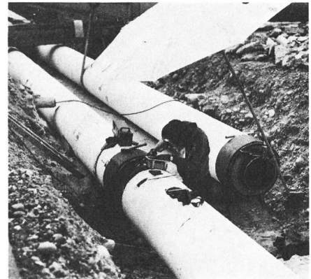
Fig. 5 Verlegung der Stahlmantelrohre
